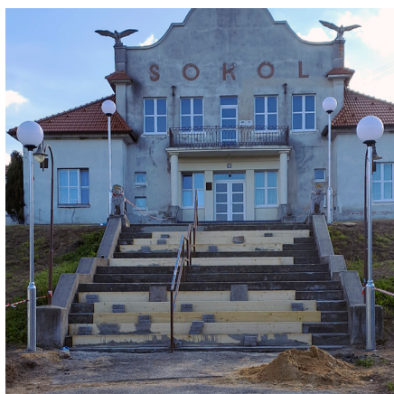
Oprava schodiště před sokolovnou.
